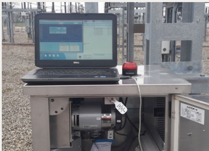
A3-206. Цифровой разъединитель для цифровой подстанции
