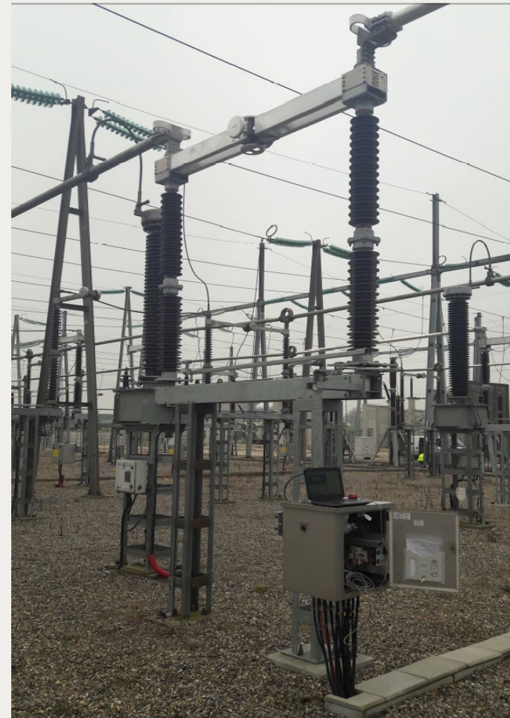
A3-206. Цифровой разъединитель для цифровой подстанции
